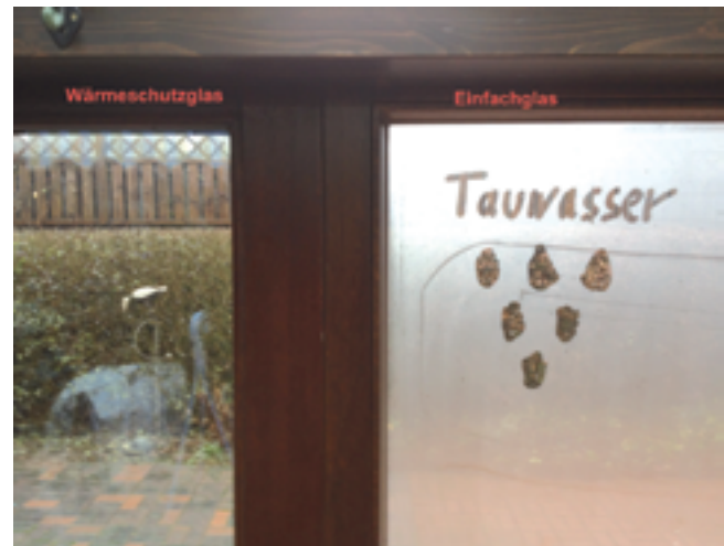
links: Wärmeschutzverglasung rechts: Einfachverglasung
